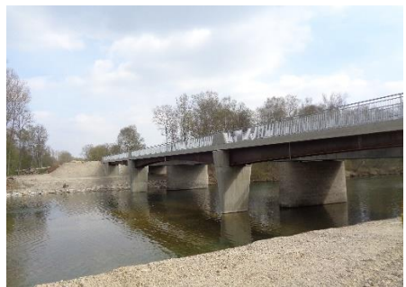
Das Foto vom 7. April 2017 zeigt es: Die neue Lechüberquerung zwischen Meitingen und Thierhaupten ist fast fertig. Eine Brücke nur für Fußgänger und Radler. 2,3 Millionen Euro wurden investiert.
