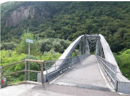
Die Radbrücke über die Etsch in Richtung Auer/Ora.
